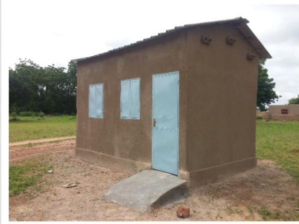
Magasin de stockage de l'école de Masgo
