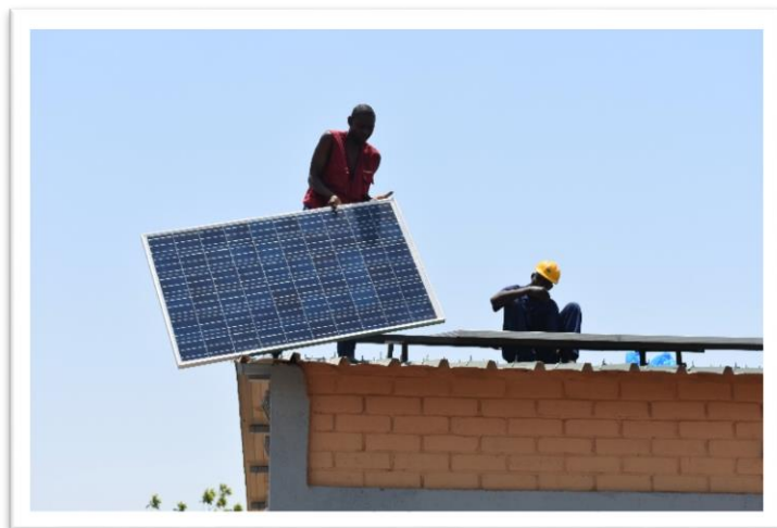
Travaux d'électrification solaire du CEG de Toudou
