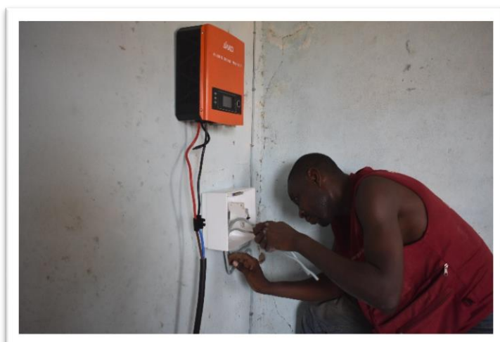
Travaux d'électrification solaire de l'école de Larga
