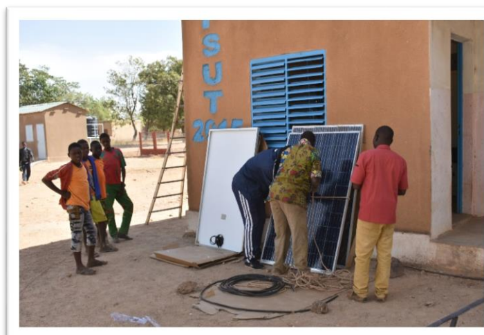
Travaux d'électrification solaire de l'école de Masgo
