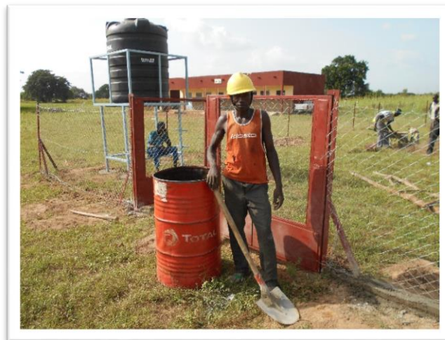
Mobilisation des acteurs locaux lors des travaux de réalisation du jardin scolaire de Larga
