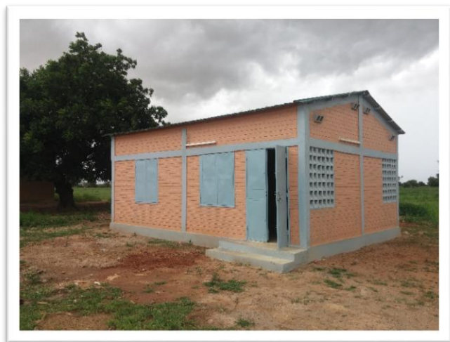
Plateforme électrotechnique du lycée départemental de Manga
