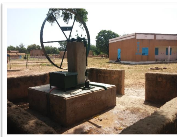
Forage de l'école de Masgo après l'adaptation
