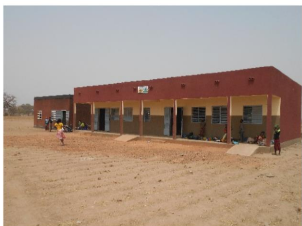
Un bâtiment de l'école de Larga
