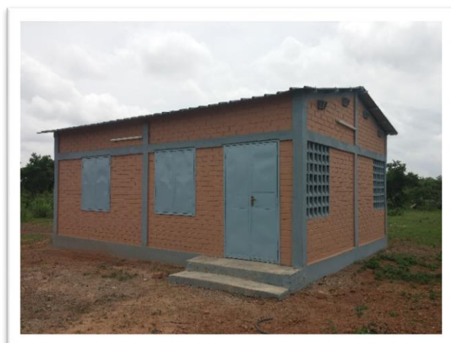
Plateforme électrotechnique du CEG de Toudou
